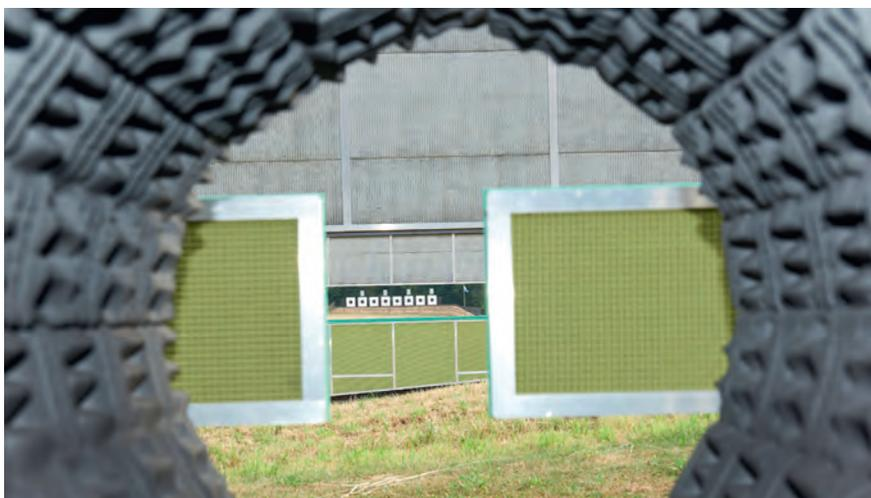
*Illustration 63: Construction d'un pare-balles latéral de proximité avec tunnel (vision du tireur)*
