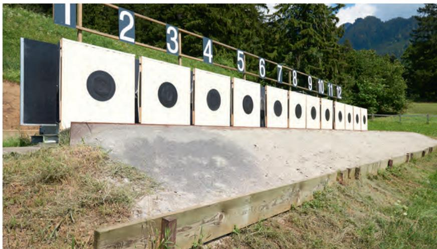
Illustration 40: Glacis pare-balles en sable avec plaque de protection montée
