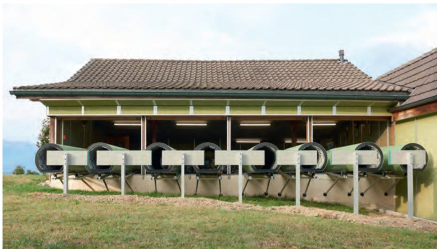
*Illustration 64: Construction d'un pare-balles latéral de proximité avec tunnel (vision de l'extérieur)*
